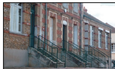
Rampes d'escaliers, 2012 ©PNR HVC
